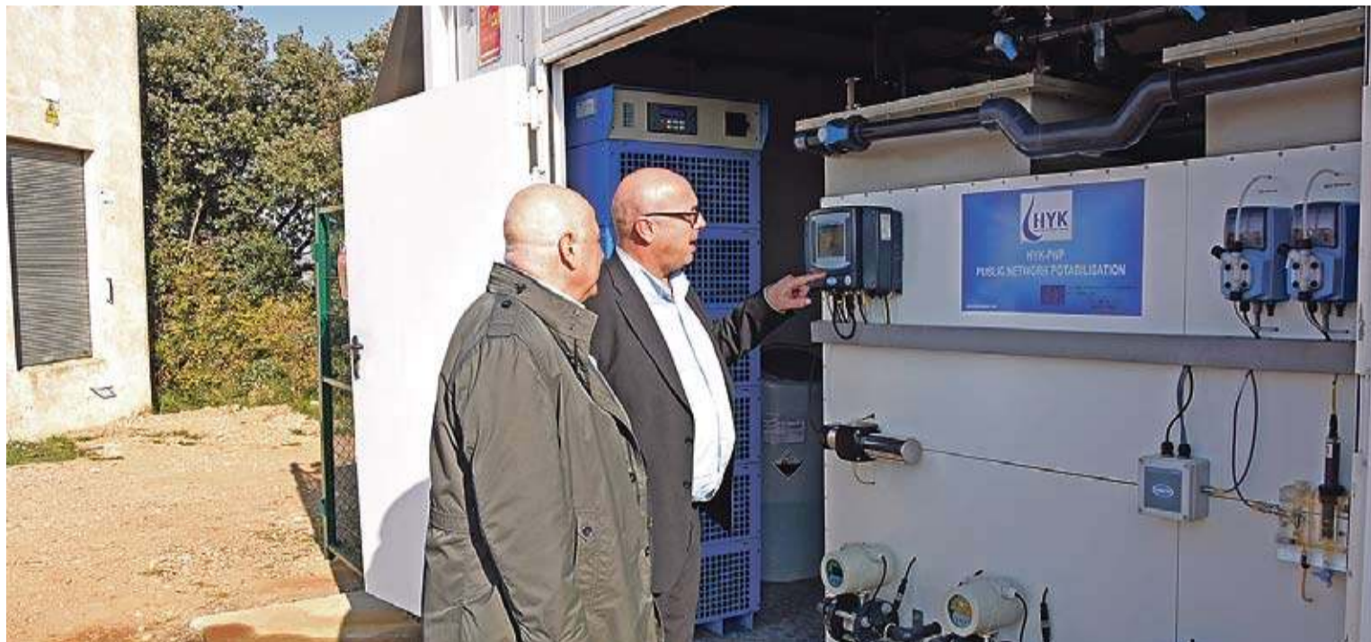
SISTEMA PIONER. La tecnologia de l'electrodesnitrificació transforma els nitrats en gas nitrogen i oxigen sense obtenir residus, com passa amb processos actuals A. REYNAL
