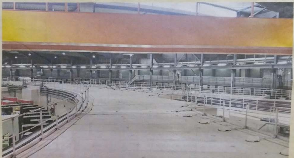
Per sota d'aquesta estructura de formigó, reforçada i aïllant, circula la llum de síncrotró
